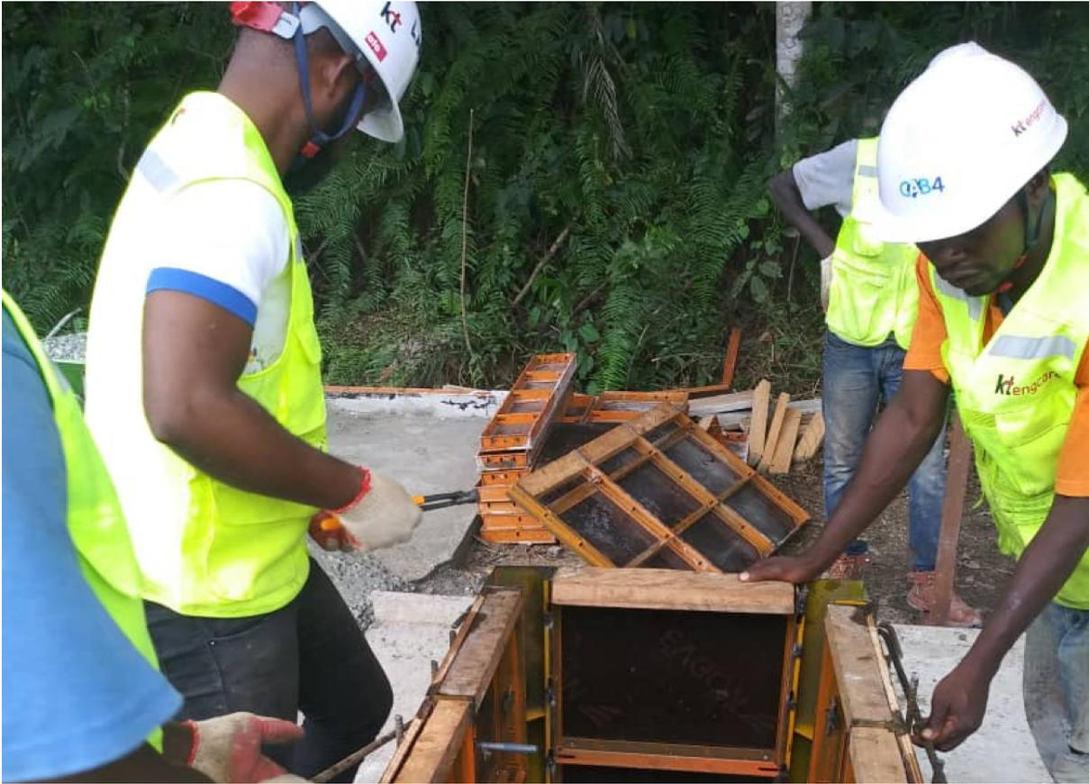
Figure 11: fabrication d'une chambre L3T
